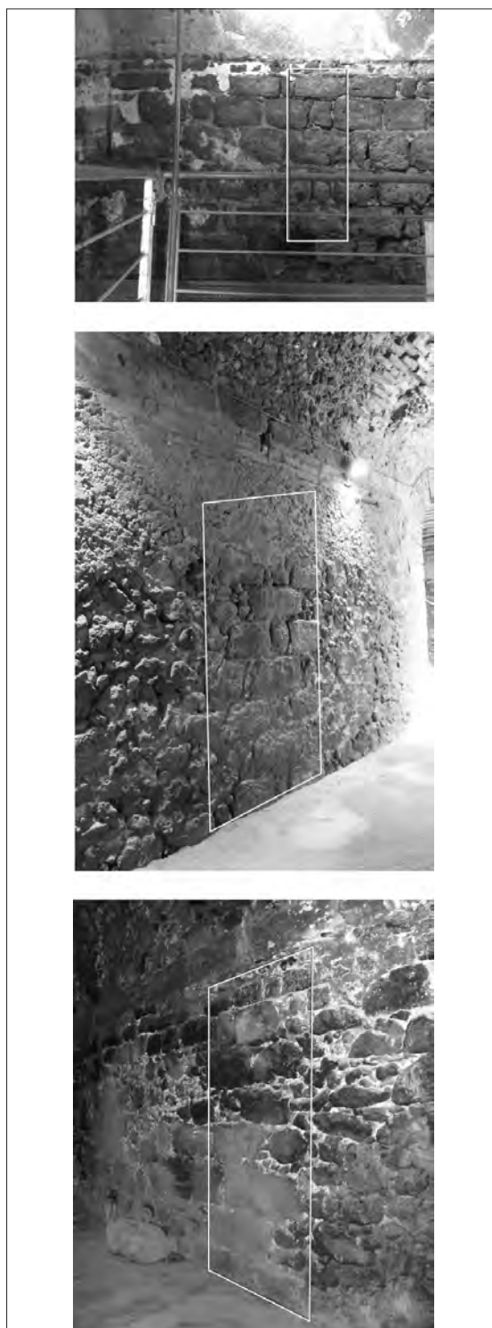
Fig. 13 - In alto: muratura della parete Est della sala centrale delle Terme Achilliane; al centro e in basso: paramenti murari con telai presso l'ambulacro del Teatro romano di Catania, nei riquadri i blocchi che per disposizione rimandano a telai verticali (foto della scrivente).
