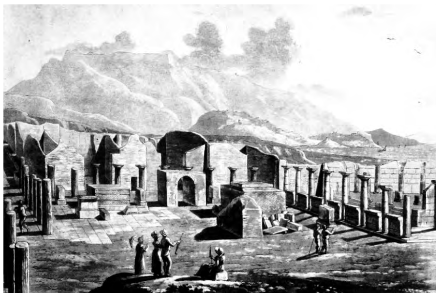
Fig. 15 - Parte meridionale del Foro, prima del 1819, secondo Henry Wilkins. (da DEMAURO 2020).
