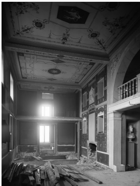
Fig. 6 - Interni della villa di Byström risalenti agli interventi del 1840 (da LEANDER TOUATI 2018).
