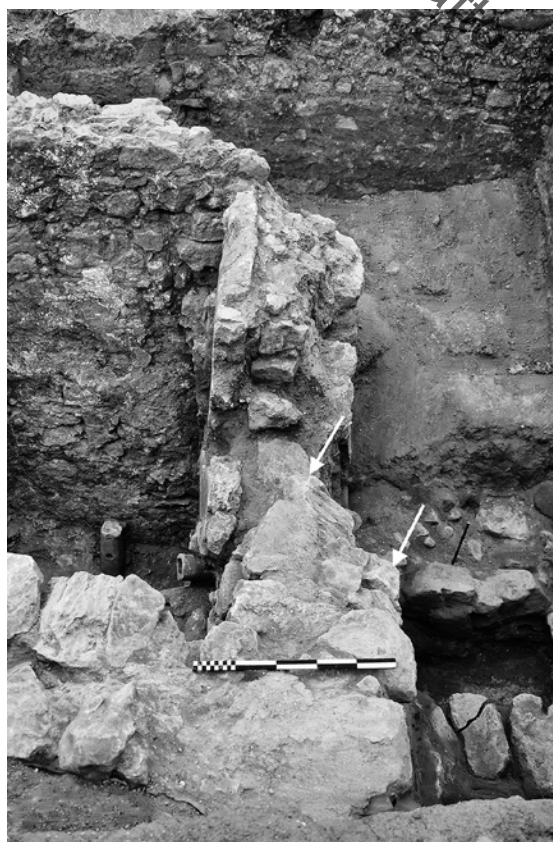
Fig. 19 - Gerace. Area D6, piscina calda rettangolare (4) alla chiusura dello scavo, da sud. La parte della parete est, in primo piano, è stata seriamente danneggiata dal terremoto (vedi frecce bianche), e la parete più oltre, con uno spesso strato di intonaco ancora in situ , sporge dalla verticale. A sinistra, all'interno della vasca, un tubulus verticale pieno di calce fa parte del sottostante ipocausto; l'altro tubulus subito a destra di esso è quello visto in fig. 18. Parte del prae-furnium per il riscaldamento delle terme è visibile sulla destra. La rampa di terra (in alto a destra) è un riempimento non scavato, lasciato in posizione per facilitare lo scavo del prae-furnium . Il muro sullo sfondo appartiene al lato sud della piscina fredda 7. Scala: 50 cm. Fotografia di R.J.A. Wilson.
