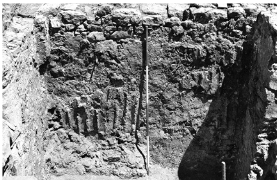
Fig. 10 - Gerace. Area D6, parete nord del caldarium , vista da sud. Le impronte nell'intonaco sono state lasciate dalla rimozione dei tubuli in terracotta durante la dismissione delle terme. Una piccola parte del riempimento è stata lasciata in posizione (in basso a sinistra) per garantire la stabilità dell'intonaco. Scala: 2 m. Fotografia di R.J.A. Wilson.
