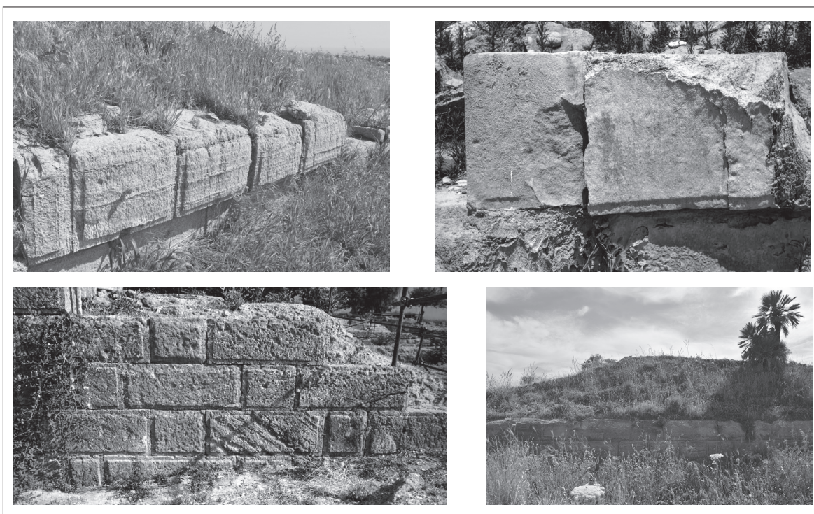
Fig. 11 - a. Eraclea Minoa, esempio di peritaenia (Foto dell'A.). b. Facciavista dei conci lapidei dell'opera quadrata nelle fortificazioni di Eraclea Minoa (Foto di A. Fino). c. Facciavista dei conci lapidei dell'opera quadrata nei terrazzamenti a nord del Poggio di San Nicola, Agrigento (Foto di A. Fino). d. Bastione rettangolare (Foto dell'A.).
