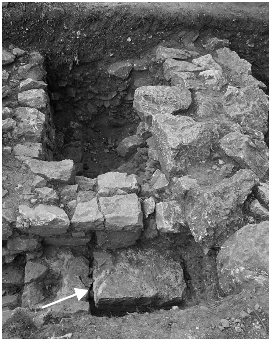
Fig. 12 - Il pilastro più occidentale parzialmente oblitterato (vista da est).
