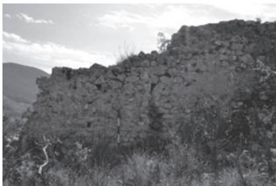
Fig. 21. Località Mbjeshovë. Particolare del prospetto interno del muro perimetrale meridionale della cinta difensiva (foto dell'A.).
