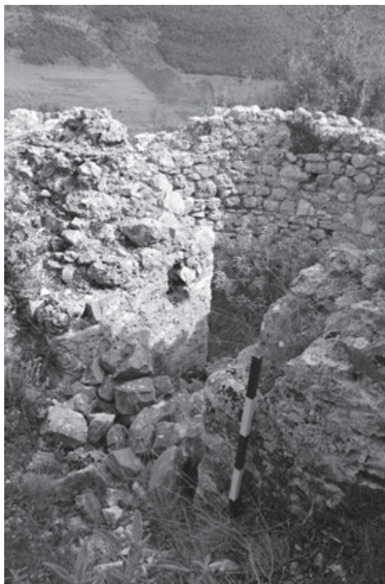
Fig. 14. Località Mbjeshevë. La torre semicircolare sudorientale, vista da nord-est (foto dell'A.).
