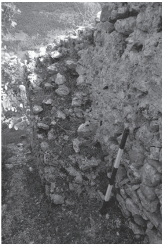
Fig. 18. Località Mbjeshevë. Rampa d'accesso al cammino di ronda ubicata presso la torre semicircolare sud-orientale (foto dell'A.).
