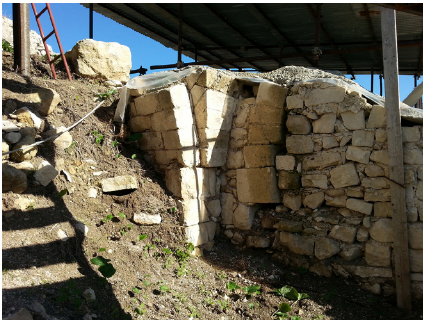
Fig. 14 - Castello dei conti: attacco delle volte a crociera nell'area settentrionale della rocca.
