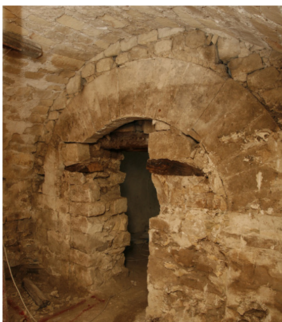
Fig. 13 - Convento del Carmine: arco con ghiera a grandi conci di tipo catalano.
