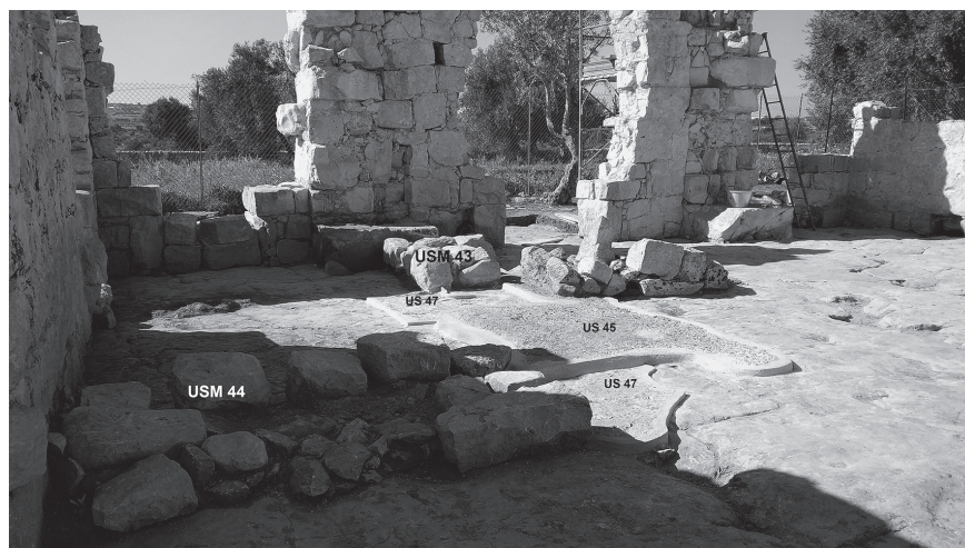
Fig. 9 - San Pancrati. L'ambiente tardo nell'angolo sud-ovest della Chiesa con le tracce del cocciopesto pavimentale e le impronte dei pilastri (US 47).
