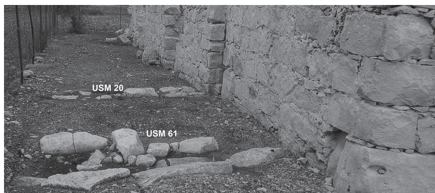
Fig. 11 - San Pancrati. Strutture murarie lungo il prospetto meridionale.
