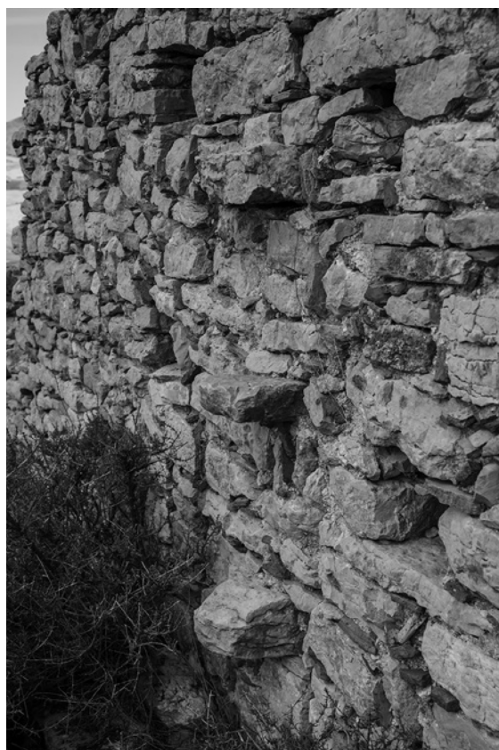
Fig. 21 - Lato sud della chiesa, borni per innesto del muro della sacrestia.
