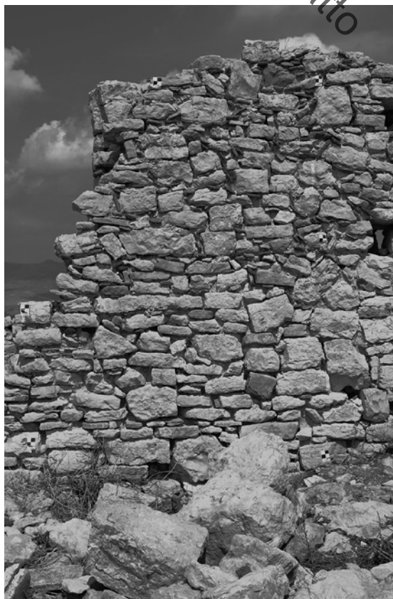
Fig. 29 - Particolare dei restauri nelle parti superiori delle pareti della chiesa.
