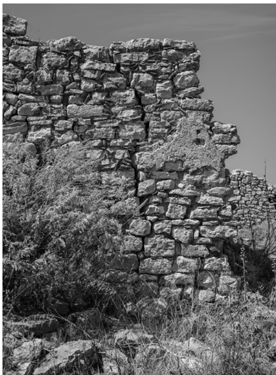
Fig. 17 - Tracce di intonaco sulla parete orientale della chiesa.
