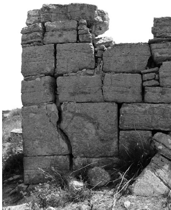
Fig. 28 - Crepa lungo la torre settentrionale riparata in epoca monastica [Image credits: C. Winterstein, 2016].
