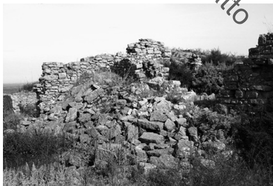
Fig. 24 - Angolo sud-orientale dell'interno della chiesa; enorme crollo probabilmente del campanile [Image credits: C. Winterstein, 2016].
