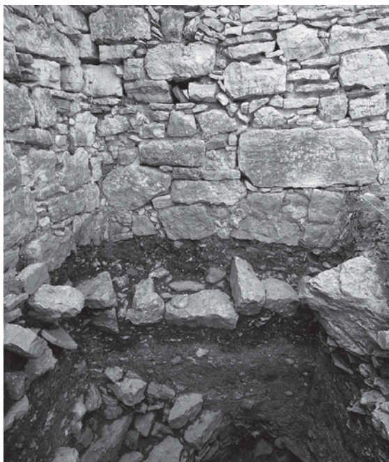
Fig. 13 - Prospetto del saggio 1. Alzato del dormitorio privo di fondazione e muri a secco con diverso orientamento [Image credits: M. Jonasch, 2017].
