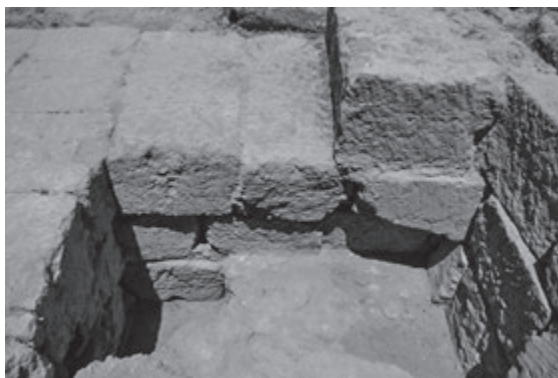
Fig. 5 – Blocchi di fondazione della torre/bastione con segni di cava (foto Archivio Università di Catania).
