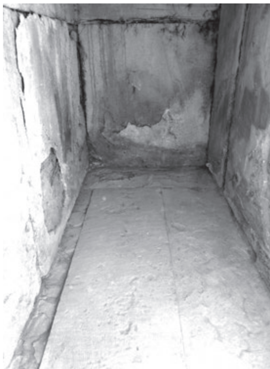
Fig. 11. Dettaglio dell'interno del vano ipogeo dell'edificio IV (foto dell'A.).
