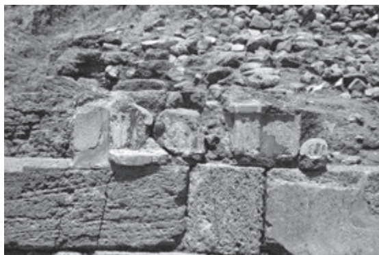
Fig. 6. Montagna di Marzo. Torre sud, lato sud, materiali di reimpiego.
