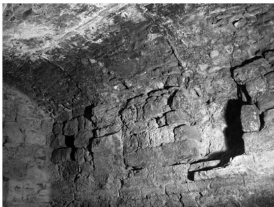
Fig. 17 - "Crocifisso". Particolare della parete sud-ovest del vano minore. Effetto dello spoglio totale e parziale di due costoloni laterizi.
