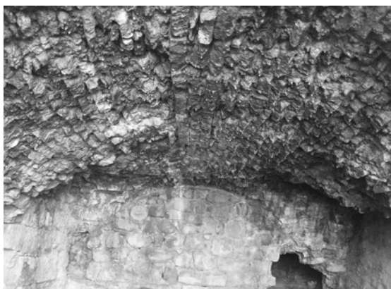
Fig. 20 - "Crocifisso". Vano maggiore. In primo piano, la volta a botte (da nord-est).
