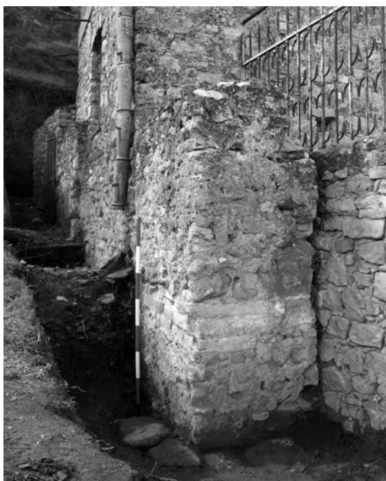
Fig. 23 - "Crocifisso". Livello superiore. Muro di contenimento in opera cementizia (da nord-est).
