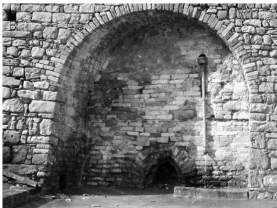
Fig. 27 - "Acqua Amara". Parete di fondo di uno degli ambienti scavati negli anni Quaranta, con sovrapposizioni moderne e l'acqua di una sorgente ancora attiva.
