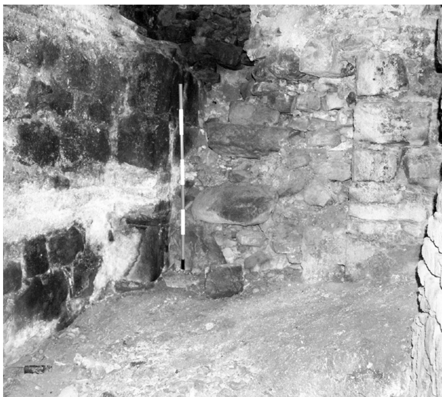
Fig. 16 - "Crocifisso". Accesso al vano minore, chiuso da un moderno muro di contenimento.
