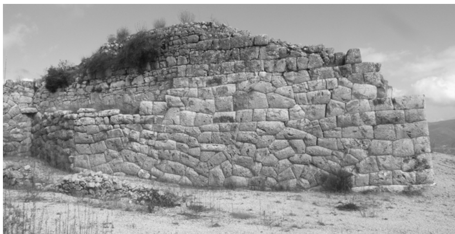
Fig. 8 - Kastritsa. Prospetto occidentale della torre triangolare, visto da ovest. In basso a sinistra è visibile una parte del proteichisma (foto dell'Autore).
