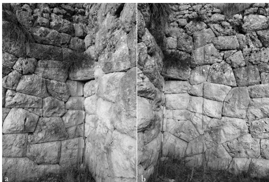
Fig. 11a-b - Kastritsa. Angolo ovest tra la torre rettangolare e la cortina muraria: a) lato della cortina con il solco che si interrompe sotto il blocco obliquo; b) lato della torre con il solco verticale posto a destra del blocco obliquo (foto dell'Autore).
