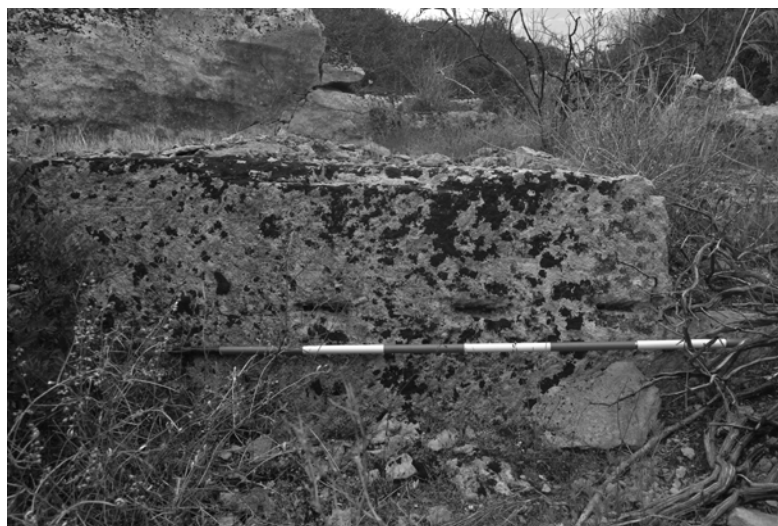
Fig. 4 - Poggio dell'Arena. Mortase per alloggiamento di cunei (foto dell'autore).
